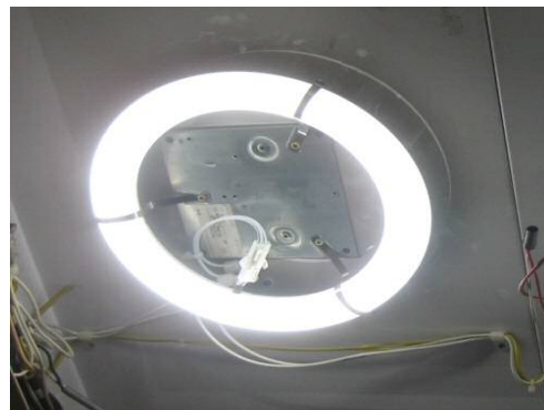
取替後（LED照明）
